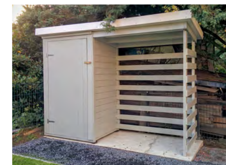
Gartenhäuschen (BxL: 0,95x2,66m) mit integriertem Holzlager (Südausrichtung)
