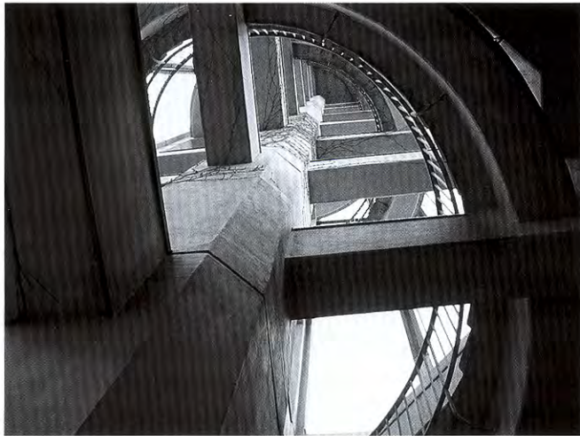
80 Blick in den Turm mit Treppenspindel, 2006
